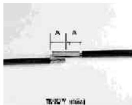
**Para 5kV como máximo:** Quite completamente toda la cera y suciedad 12,7 cm hacia atrás de cada extremo del cable. Prepare los extremos del cable exactamente como se muestra. No corte el aislante mientras retira la funda exterior.
