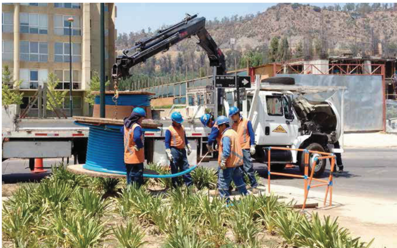
Instalación de un cable XAT en forma subterránea.
