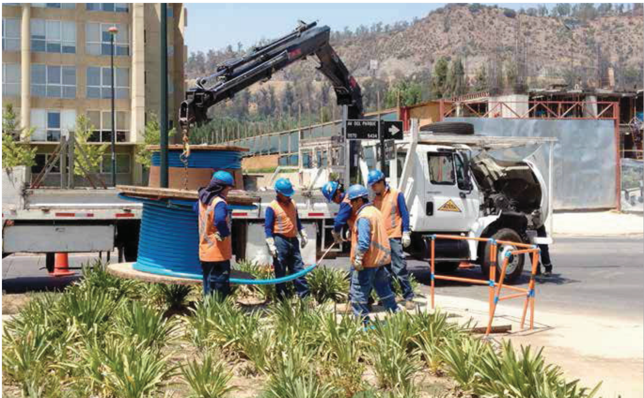
Instalación de un cable XAT en forma subterránea.
